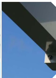
stabile Eckverbindung der Dachkonstruktion
