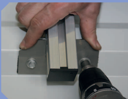
Verschraubung mit dem Dach
